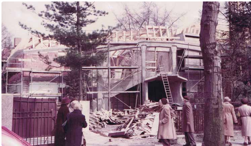
Rudolf Steiner Haus, Baustelle 1982/83
