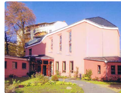
Außenansicht des Gemeindebaus mit Kirche, Schwedter Str. 4 (Architekt: A. Ringler)
