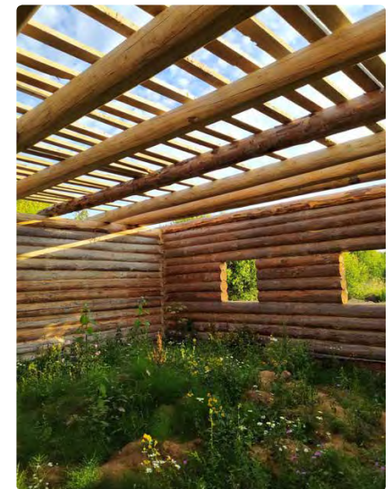
Das zukünftige Seminarhaus, noch im Baustadium
