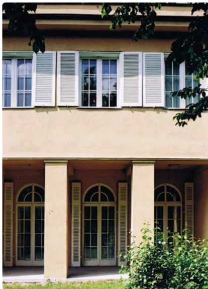
Südseite Haus Perls mit Loggia vor der Musikwerkstatt
